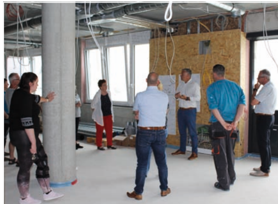
Musterwohnung (oben) Baustellenbesichtigung durch Mitarbeiter der BGO (unten)
