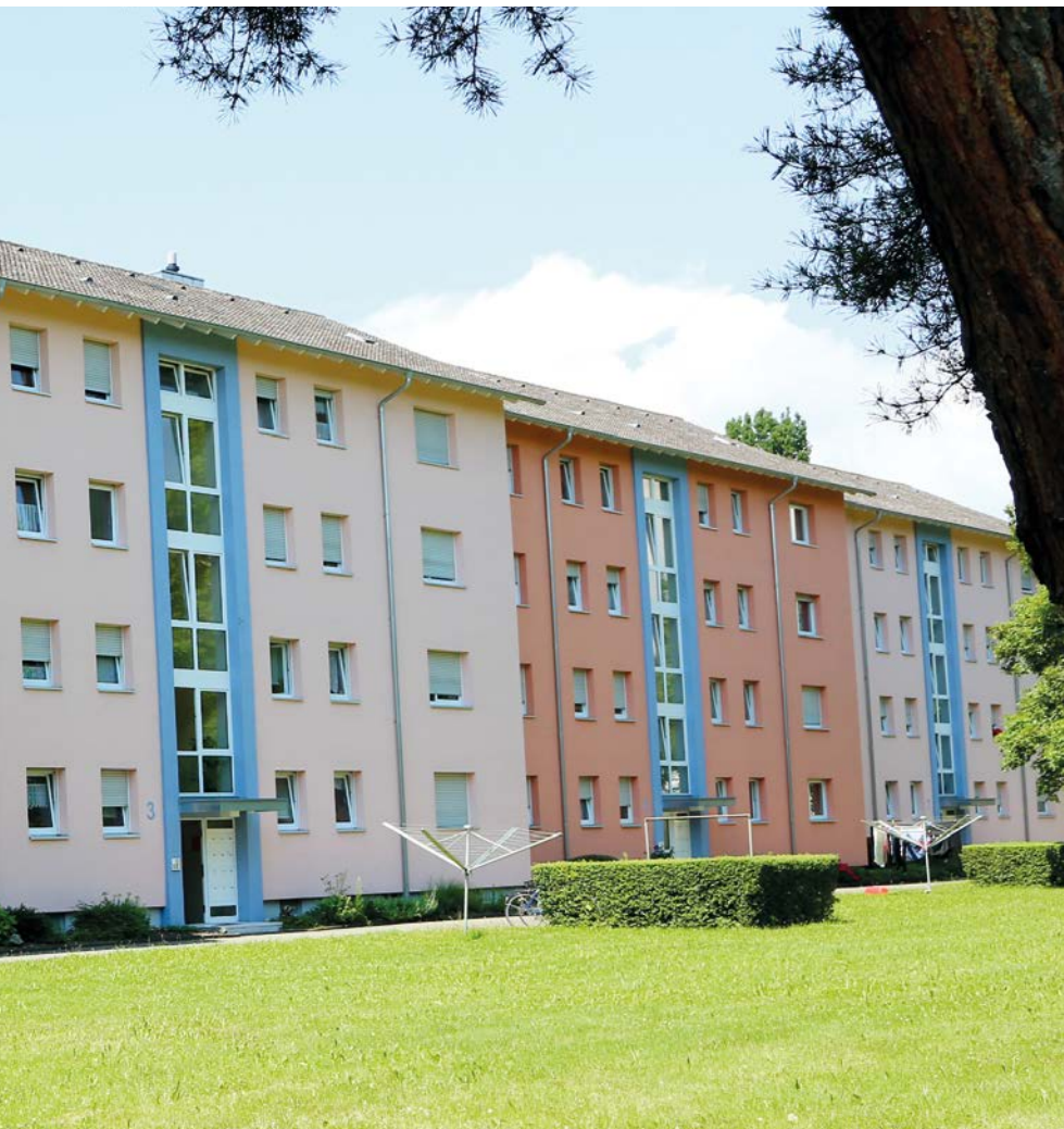
Fassadenreinigung im Malvenweg
