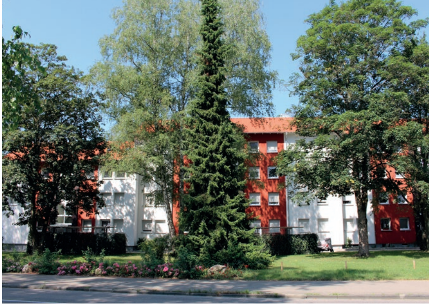
Im Herbst/ Winter finden Baumstütz- und Baumfällarbeiten im Oberzellerhau statt. Viele Bäume sind zu groß geworden.
