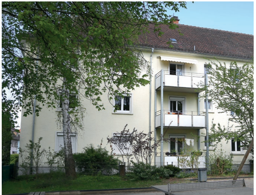
Die alte Ölheizung in der Grenzstraße 3 wurde durch eine effizientere Gasheizung ersetzt.
